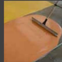
**PAVIMIX FF SKIN** è finitura autolivellante ultrafine per superfici molto lisce per spessori massimi di 1,5 mm, ad altissimo dosaggio in polimero, permette la sua applicazione su fondi regolari dall'adesione complessa.
